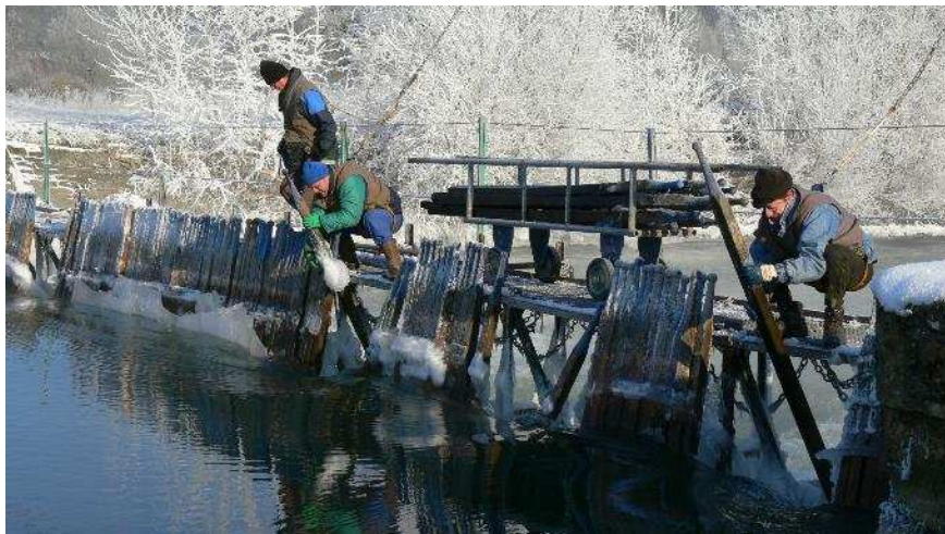
Manœuvres hivernales sur un barrage à aiguilles
