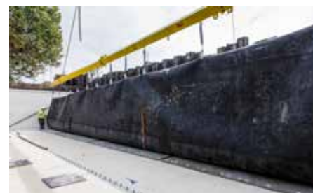
Retournement et fixation de la bouchure grâce à une palon
