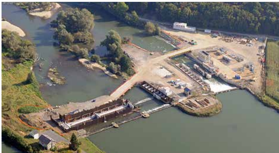
Barrage de Ham-sur-Meuse. Vue aérienne Christian GALICHET
