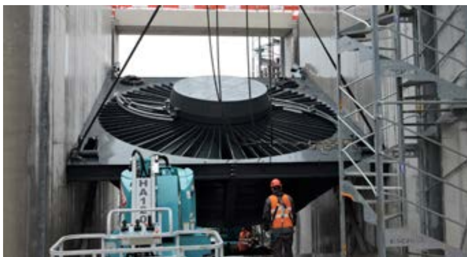
Barrage de Givet (08) : pose d'une turbine de la microcentrale
