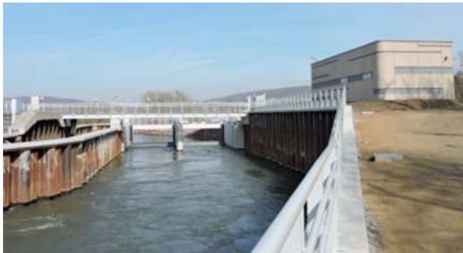
Barrage de Givet (08) : local technique et canal de dérivation de la microcentrale
