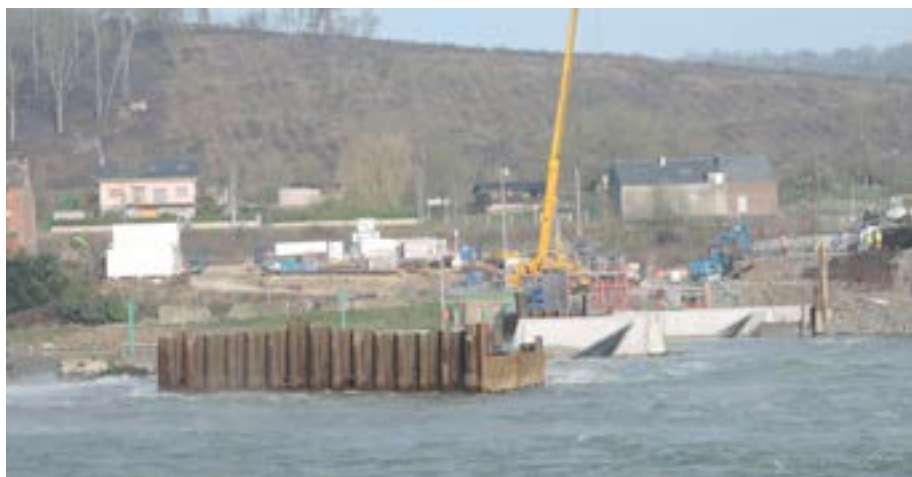
Chantier de Mouyon à Vireux Wallerand (08)
