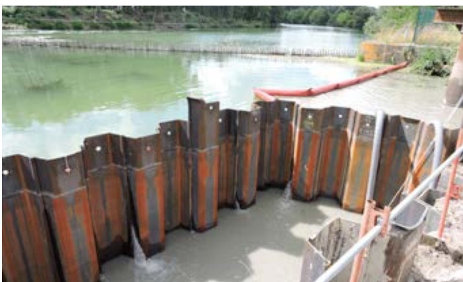
Barrage de Carandeu (60) : batardeau de la passe à poissons
