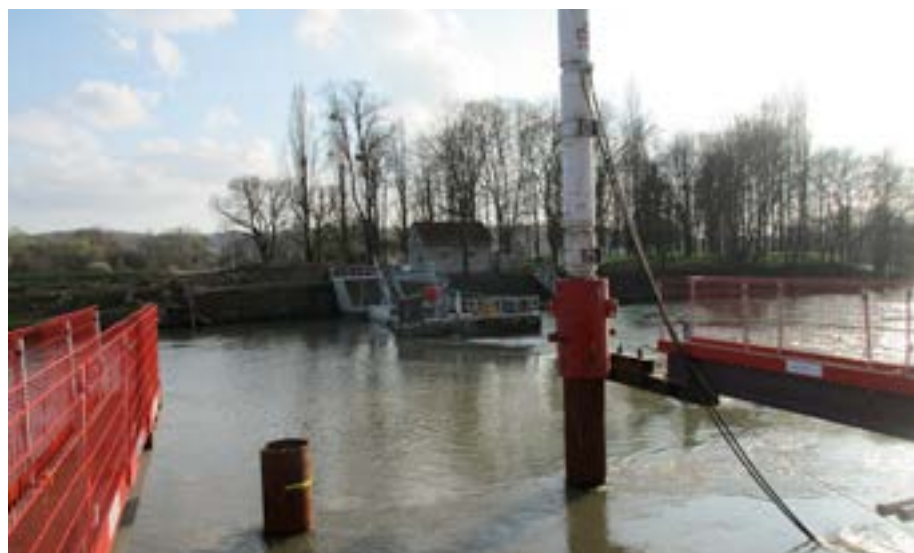
Barrage de Couloisy (60) : pose des pieux devant soutenir l'estacade
