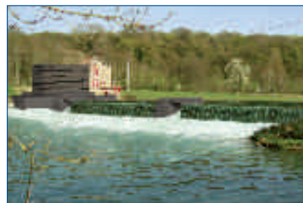
Photomontage Barrage ALMA équipé de bouchures gonflables à l'eau
